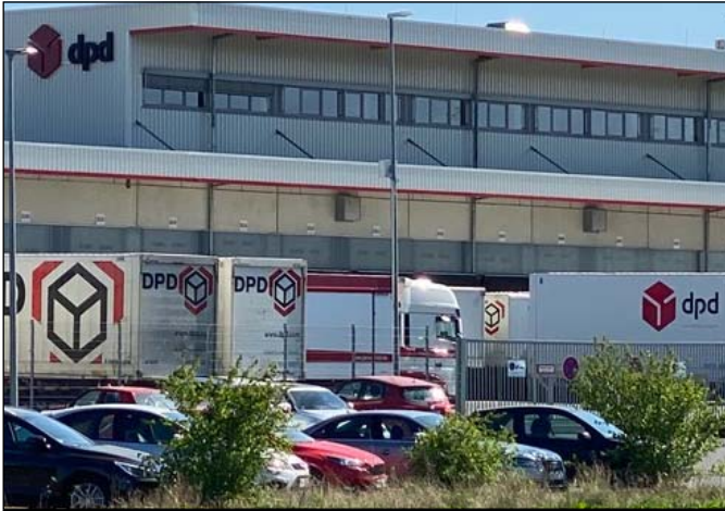
Logistikzentrum in Erftstadt Lechenich. Die Hallen sind bei Investoren so gefragt wie niemals zuvor.
