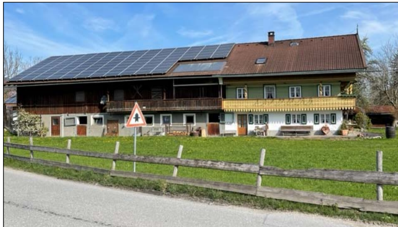
Solaranlage auf dem Dach. ESG bedeutet jedoch mehr als saubere Energie.
