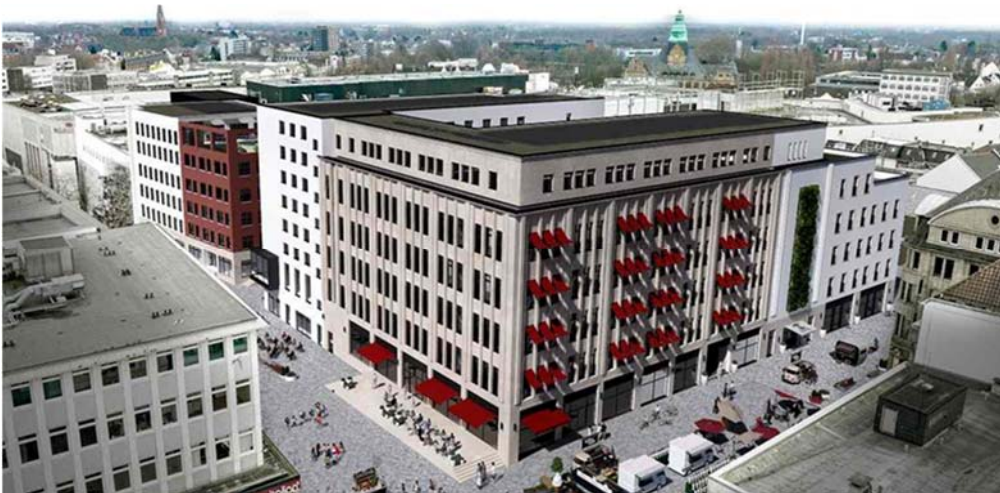
Aus Karstadt wird das Markt Quartier Recklinghausen.
