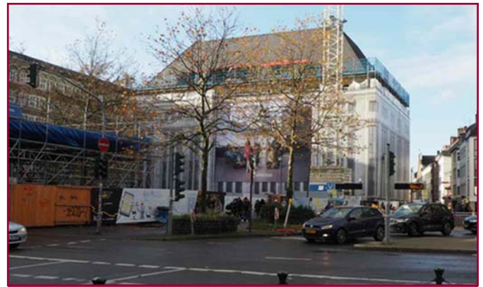
Großbaustelle Carsch Haus.
