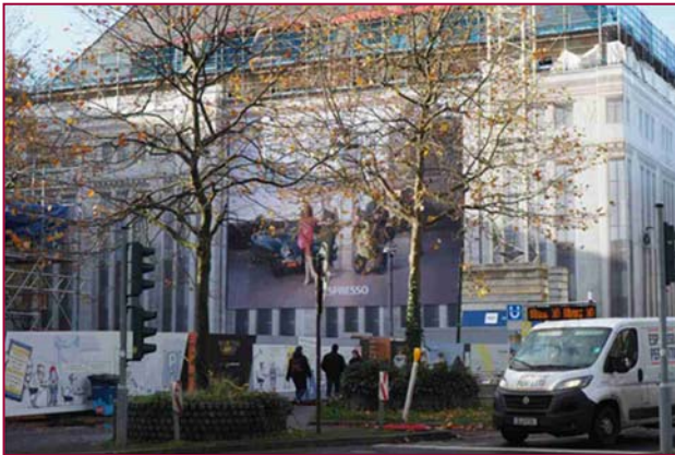
Baustelle Carsch Haus. Foto: R. Vierbuchen
