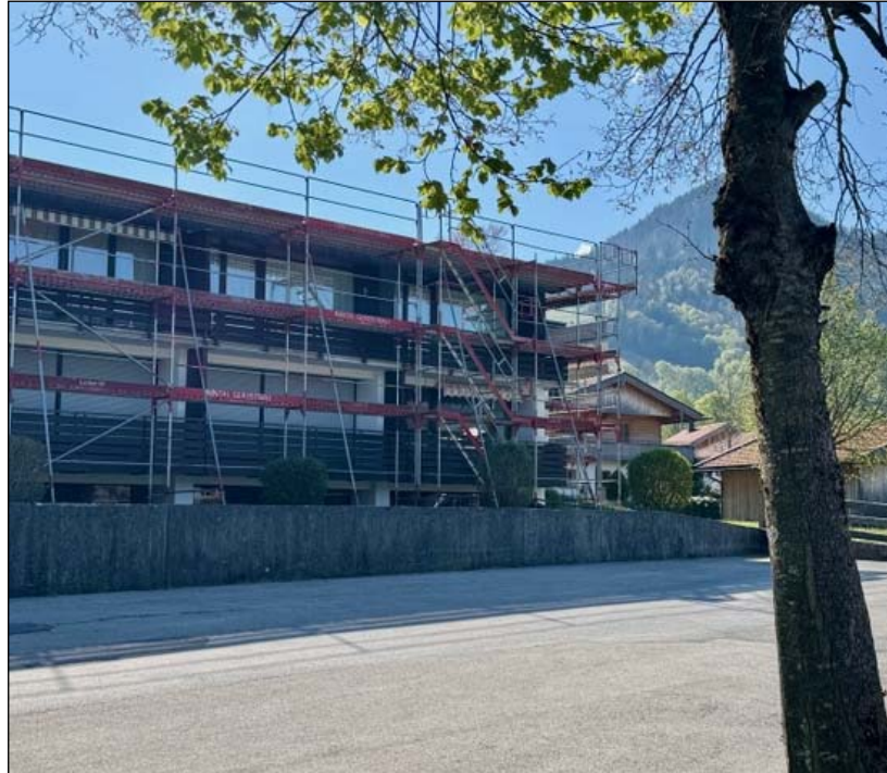
Sanierung von Bestandsbauten. Das ist das Konzept der AIF von Primus Valor.
