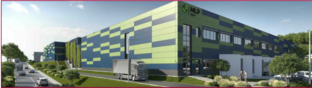
Im Bau: Der MLP Park in Idstein.
